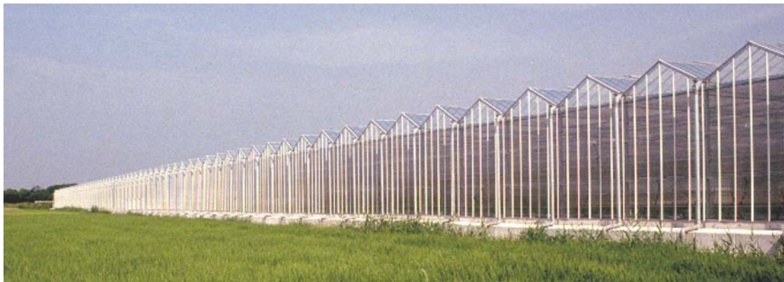
写真1 フェンロー型の大規模施設（面積約1.6ha） 幅が3.2mの棟を連続して並べてあり、軒高は4.5mです。
