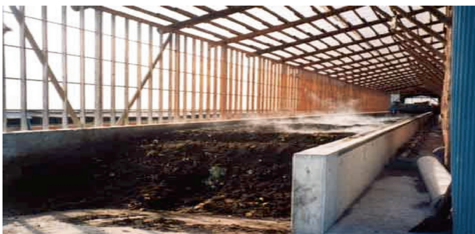
通気式堆肥舎（有限会社 国分農場（福島県））
