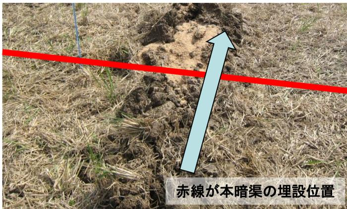
図3 籾殻弾丸暗渠施工の留意点1
