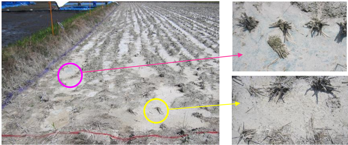
図 5：9 日後の固化状況（現地試験）
