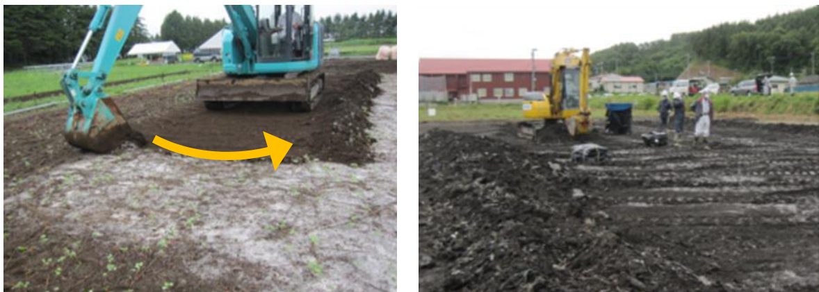
図 5：バックホーによる削り取り（左）と集積及び搬出（右） （固化剤を散布したほ場での試験）
