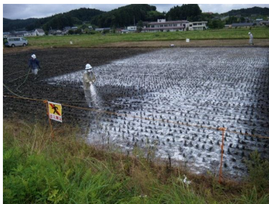
図 4：固化剤混合スラリーの散布
