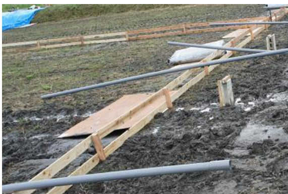
図1 水槽壁として柵を設置
