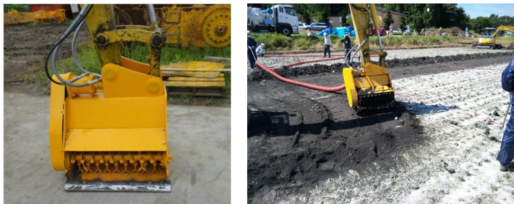
図7：バケット部分の改良（左）と表土の削り取り（右）
