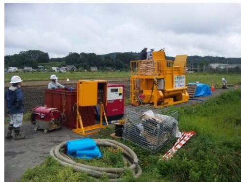
図 3：固化剤の投入
