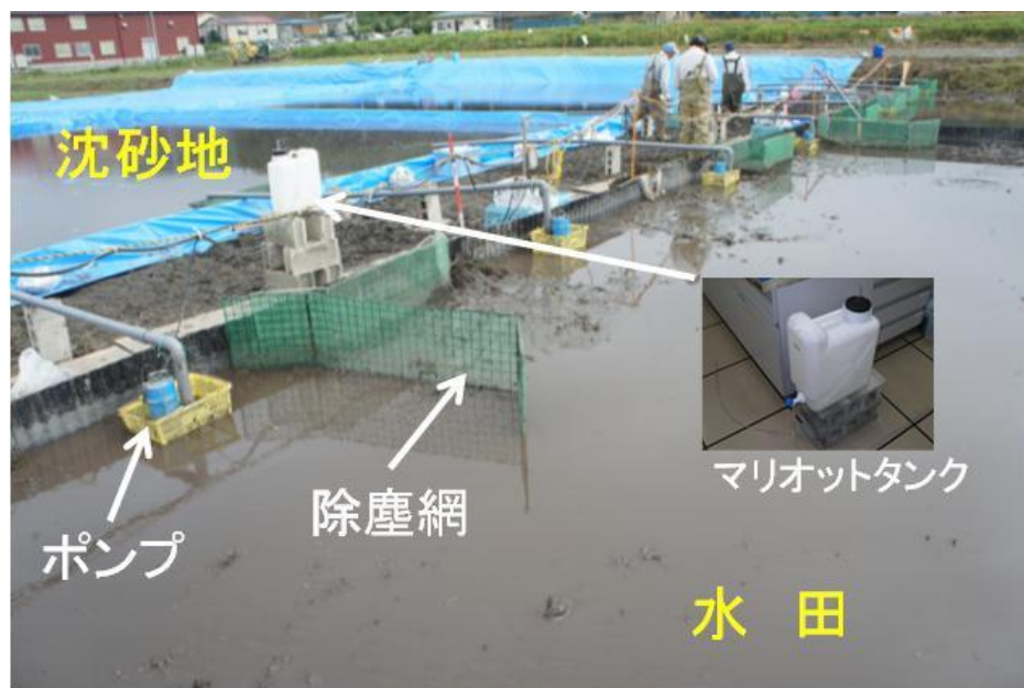
図 5 排水ポンプ設置状況
