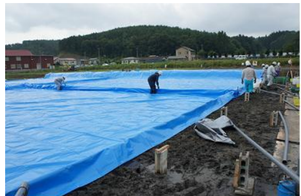
図2 工事用シートで作製した沈砂地
