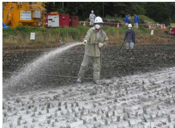
図 4：固化剤混合スラリーの散布
