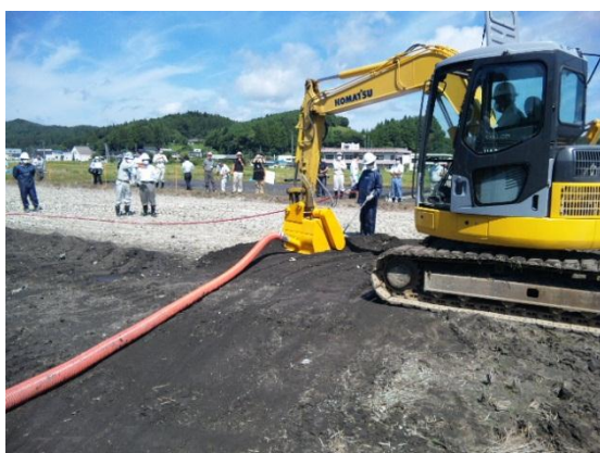
写真3：表層土の削り取り
