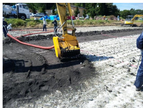
写真4：改良したバケット部
