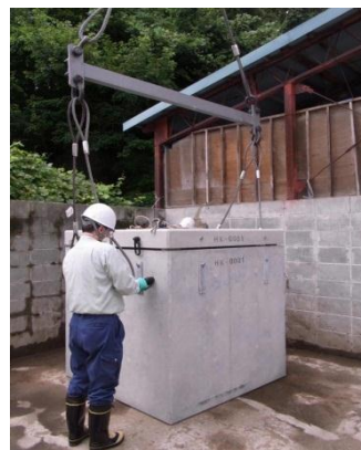
写真1：コンクリート製容器の設置
