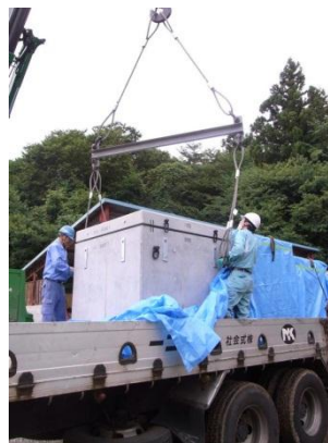
写真1：コンクリート製容器の設置
