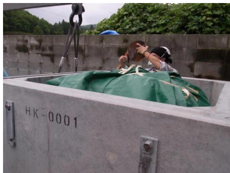
写真2：フレコンバッグ挿入後の状況
