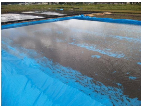
写真3：沈砂地における固液分離
