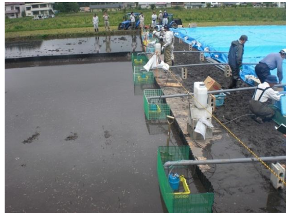
写真2：沈砂地への濁水の排出
