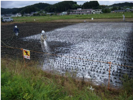
写真 1 : 固化剤吹き付け作業
