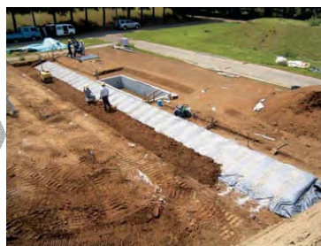
② 土のう背面に裏込め材を撒きだした状況。
