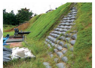
⑥ 紫外線による土のうの劣化防止のため、植生で覆土。
