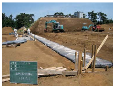
① 所定の傾斜角度を付けて基盤面を形成。
