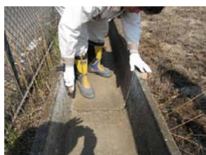
補修部分の清掃
