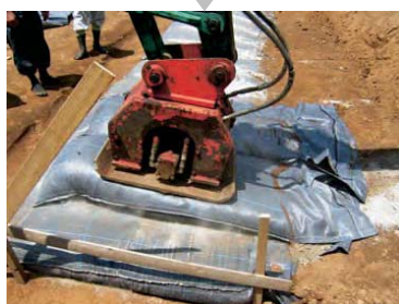
④ 土のうをしっかり締固めます。
