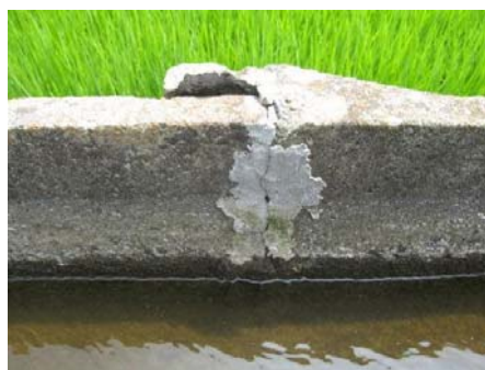
温度変化による目地幅の伸縮現象
