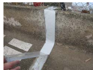
施工表面の透明保護フィルムを取り除き。
