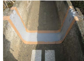
シーリング材の敷均
