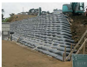
⑤ 土のうを所定の段数まで積み上げます。
