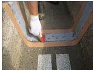
シーリング材の塗布
