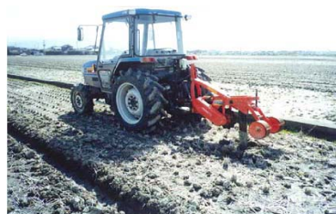
・弾丸暗きょの施工
