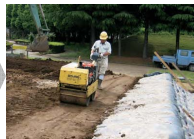
③ 土のう背面の裏込め材と土のうを締固め。
