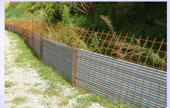
↑「忍び返し」の施工例（滋賀県日野町）
