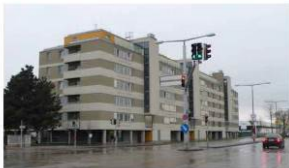
図1 ウィーン市内に建設された CLT を用いた 7 階建ての木造共同住宅 1 階は鉄筋コンクリート造、2～7 階は CLT 構造である。
