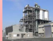
木質バイオマス発電
