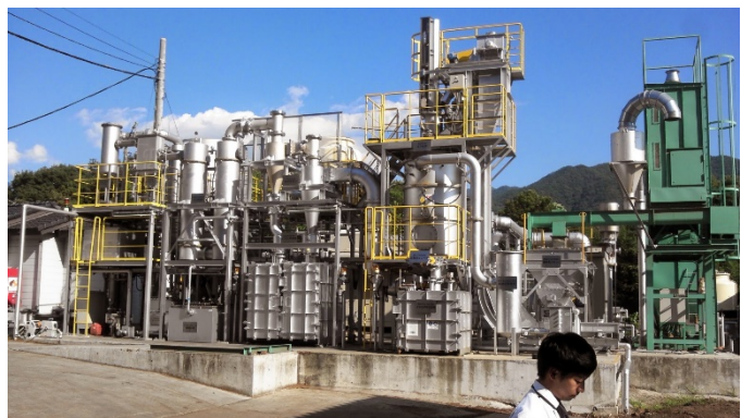
木質バイオマスガス化発電装置
