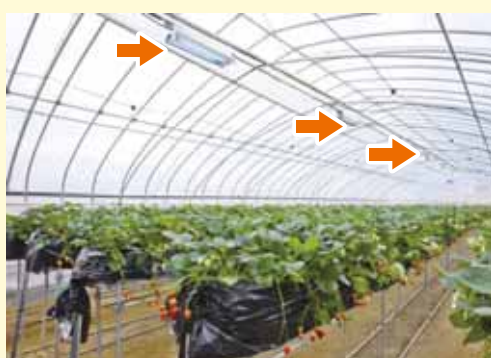
ハウス内に設置された紫外光蛍光灯
