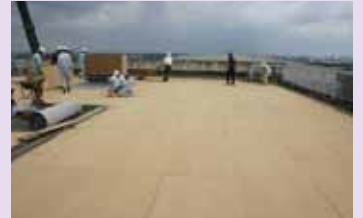
(2)保水資材を設置
