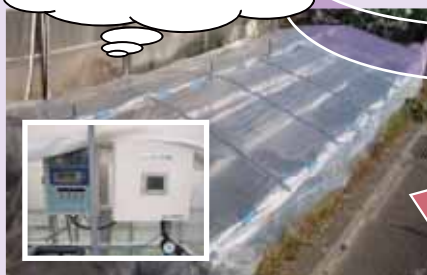
図2 光触媒処理装置と制御装置
