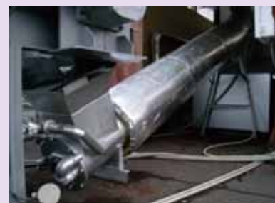
図3 蒸気と排ガス利用による 樹皮含水率低減装置
