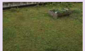
(6)1年後の緑化した屋上
