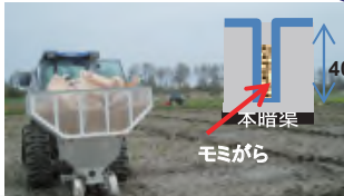
籾殻補助暗渠を施工
