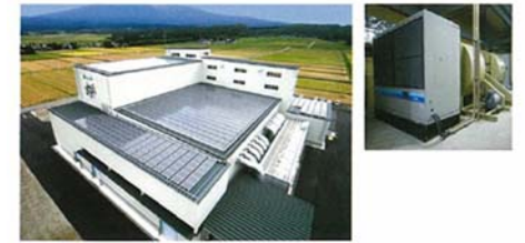
農業施設 カントリーエレベーター(穀類乾燥調整貯蔵施設)
