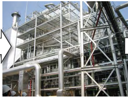
発電所(タイ10MW)
