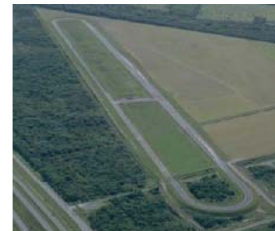
苫小牧寒地試験道路 (冬期道路管理、交通安全対策、道路構造、積雪寒冷地の気象条件を考慮した舗装設計法の確立に向けた試験などを実施)
