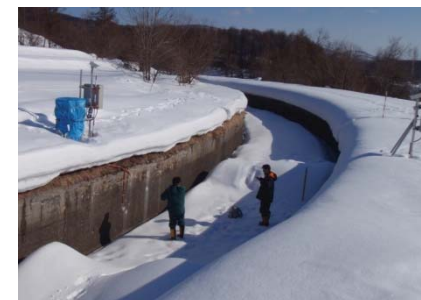
コンクリート水路の劣化調査 (凍結融解作用による劣化メカニズム 1 検証のための現地調査)
