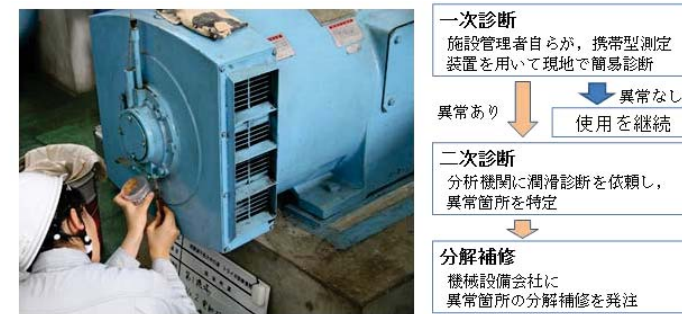
SIPの中で新潟・愛知県の機場を対象に実証試験
