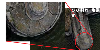
画像によるひび割れ等の判別例
