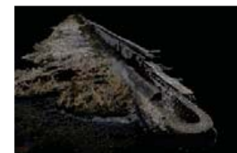
撮影した画像から生成した海岸堤防の三次元モデル
