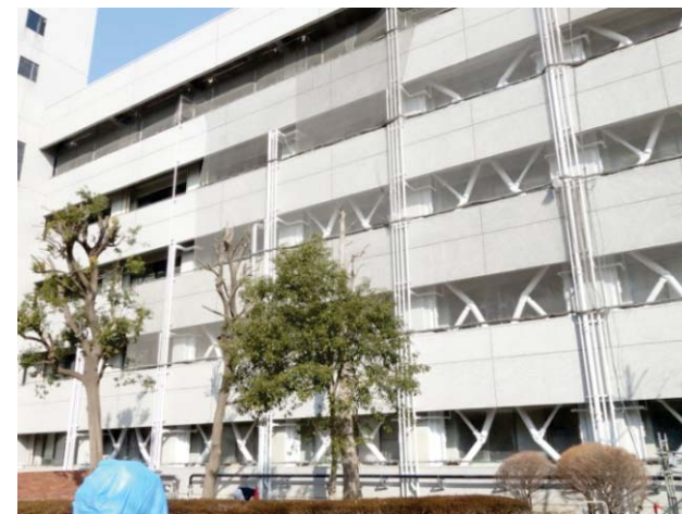
研究本館耐震改修工事
