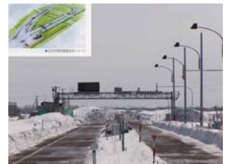
石狩吹雪実験場 (吹雪視程障害や吹きだまりの実験施設)
