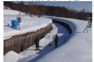
コンクリート水路の劣化調査 (凍結融解作用による劣化メカニズム検証のための現地調査)
