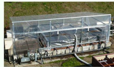
浄化処理施設の温室効果ガス測定システム
