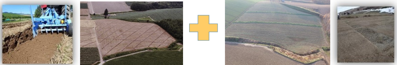
土層改良の実施(カットソイラー)
