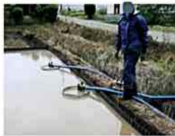
② ポンプによる濁水の排水
