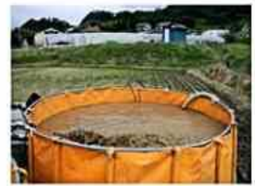
③ 濁水の貯留、凝集剤添加による土壌粒子の沈殿
