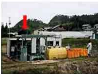
④ 加圧ろ過装置（写真矢印）による水と土壌粒子の分離
