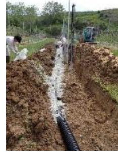
排水対策として暗渠敷設 リンゴでの排水対策効果
