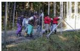
大人数での柵の設置作業
