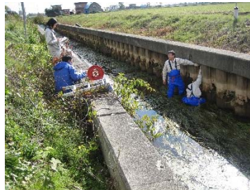
凍害・摩耗を生じた頭首工
