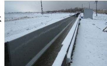
更生後の開水路
