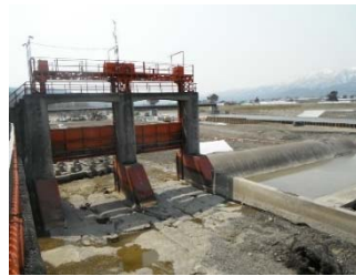
凍害・摩耗を生じた頭首工
