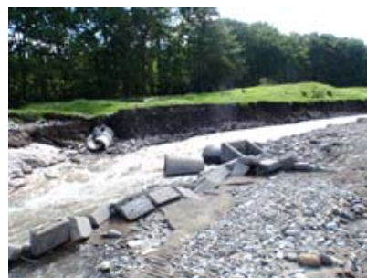
写真-1 水路護岸の損壊と路面の侵食状況
