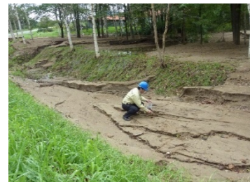
排水路内への土砂堆積 (新得町)
