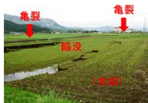
農地に発生した亀裂・陥没 (阿蘇市)
