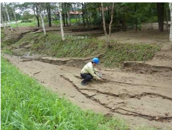
5. 排水路内への土砂堆積(新得町)
