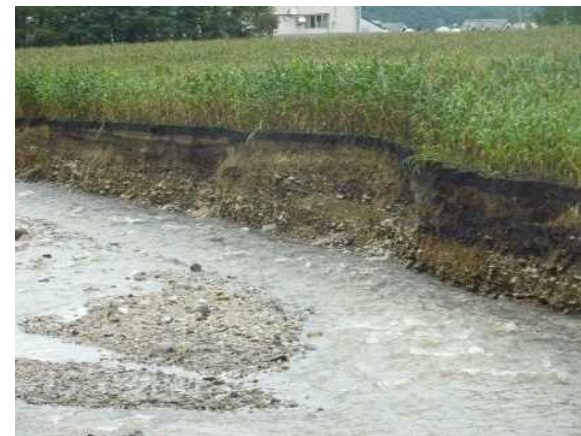
3. 護岸の洗掘による農地の崩落(新得町)
