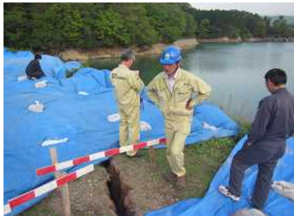
1. ため池堤体に発生した亀裂(宇城市)
