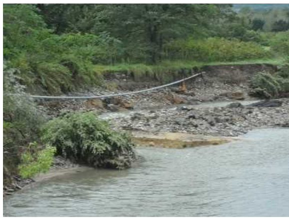
2. 護岸の洗掘によるパイプライン等の損壊(新得町)
