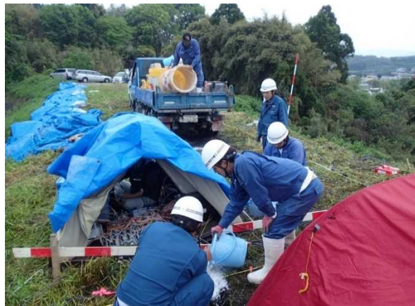
2. ため池堤体の亀裂深調査(宇城市)
