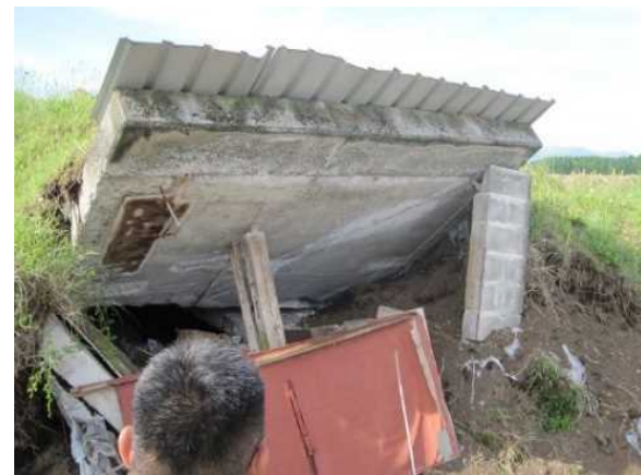
6. 甘藷貯蔵庫の崩壊(西原村)
