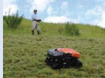
無線草刈機の運用に対応した傾斜
