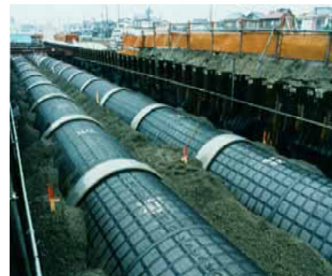
東海農政局における浅埋設工法採用事例
