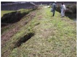
堤体の陥没
