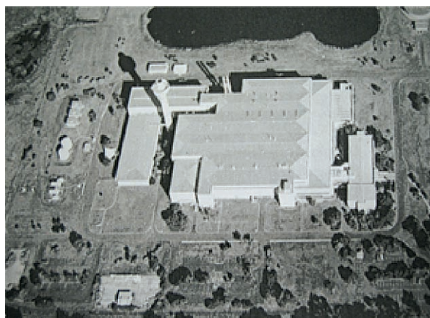
AAHLの研究本館 (建物の内部に向かって陰圧が段階的に強くなる構造になっており、病原微生物が封じ込められる仕組みになっている)
