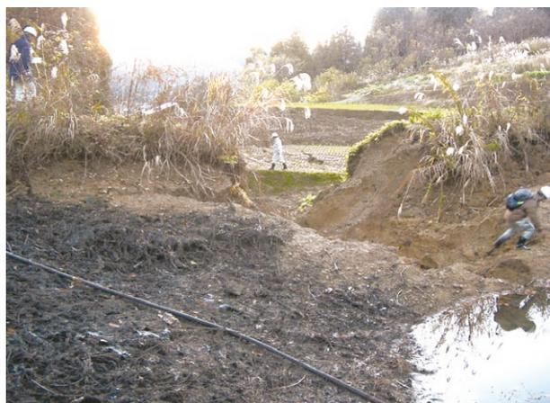
被災したため池の様子（左岸貯水池側から堤体を下流方向に撮影、右手が貯水池、堤体の後ろ左側が下流方向）
