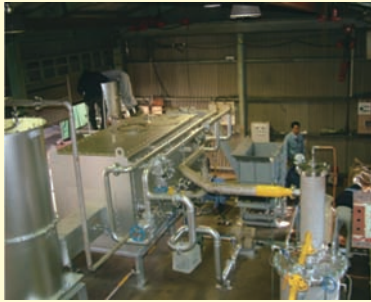
農林バイオマス 3号機 (長崎県諫早市)
